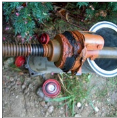
Beschädigte Hauptabsperungen
